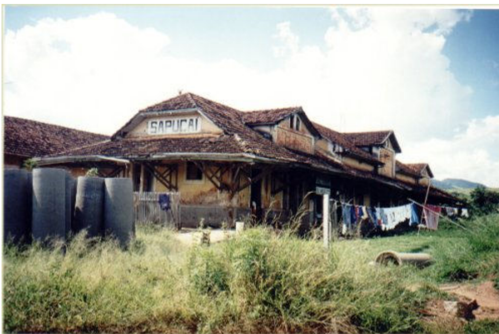
Figura 31 - A estação de Sapucaí, no abandono, em 18/03/1999. Disponível em http://www.estacoesferroviarias.com.br/s/sapucaí.htm
