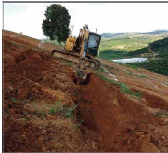
Figura 10. Abertura de sulcos em áreas declivosas utilizando a retroescavadeira. Marcação das linhas utilizando calcário.
