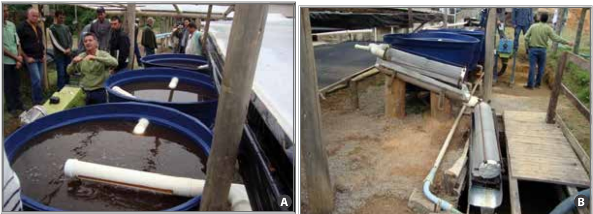
Figura 9. Caixas de decantação (A); peneiras do sistema de limpeza de águas residuárias (B).
