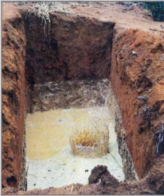
Figura 12. Caixa-seca construída na área interna da lavoura para redução do fluxo superficial e captação de água das chuvas.
