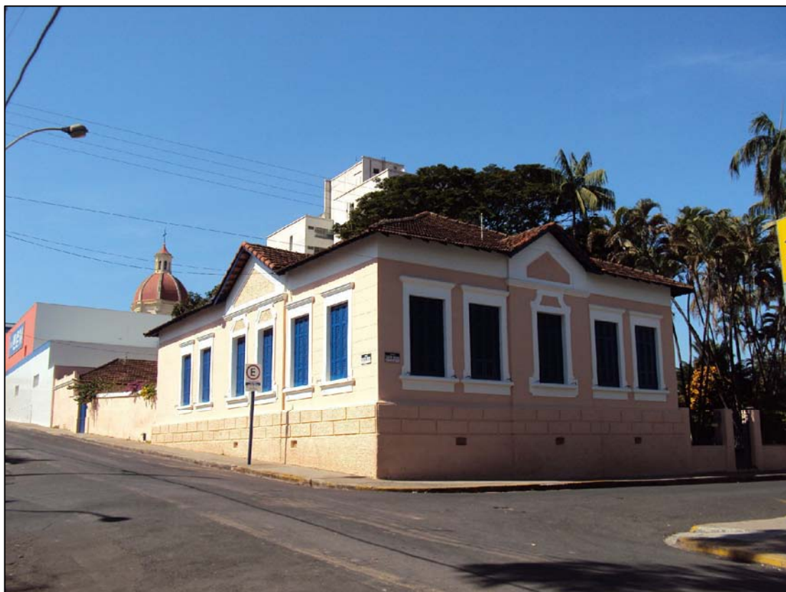
Vista do casarão a partir da Praça João Plínio Fernandes, atrás do Grupo Escolar Almeida Vergueiro. 2010.
