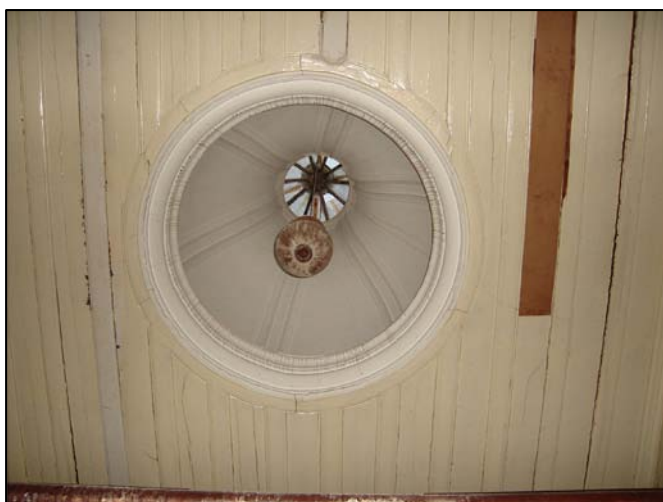
Iluminação zenital do pavimento superior, com lustre original.
