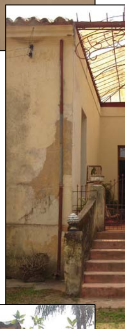
Paredes externas, com rachaduras e umidade.
