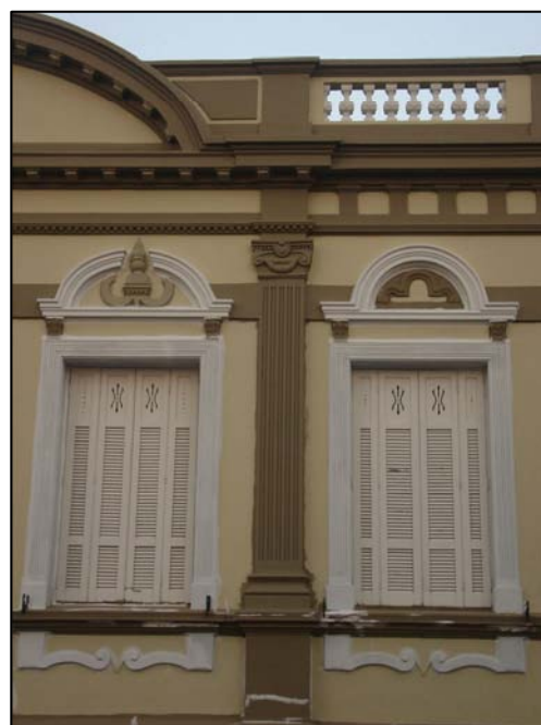
Detalhe de composição da fachada, vendo-se pilastra e platibanda com balaústres.
