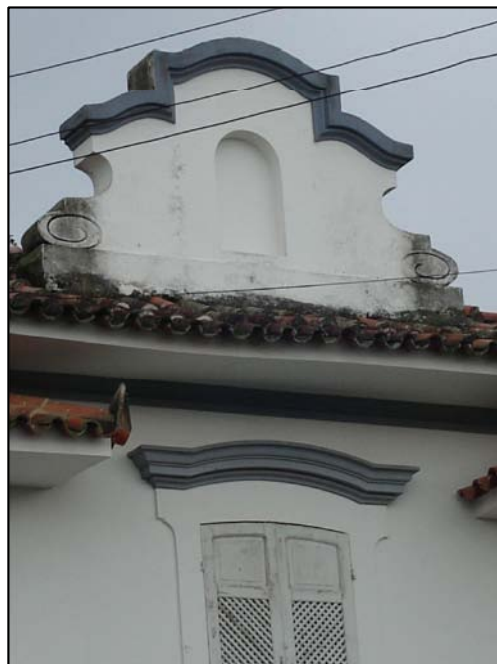
Detalhe do frontão.
