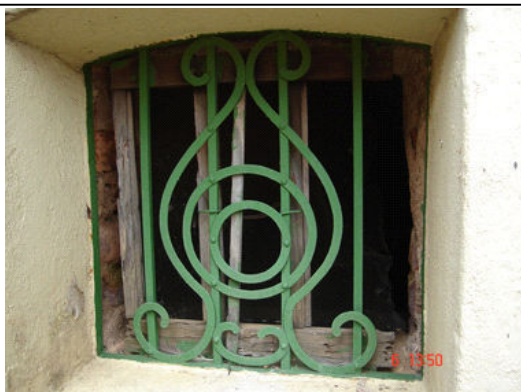
Óculos de ventilação dos porões, sob as aberturas.
