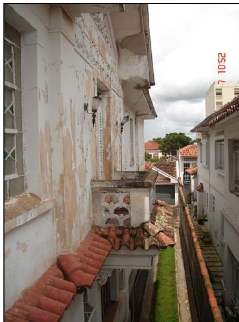
Fachada lateral, com vista da sacada de dormitório.
