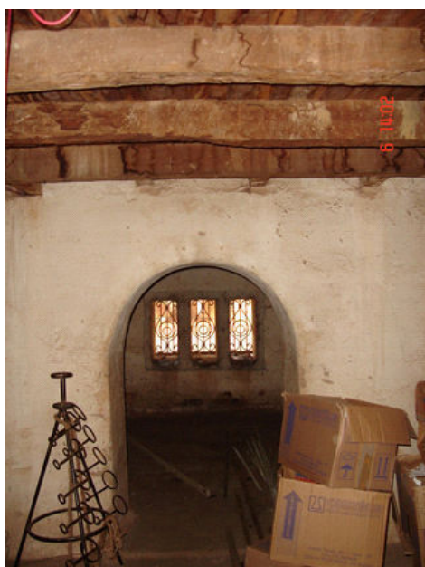
Vistas do porão, com as vigotas em madeira aparecendo.
