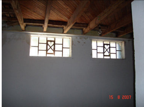
Pilar, vigotas de sustentação do piso assoalho, e janelas, no porão.
