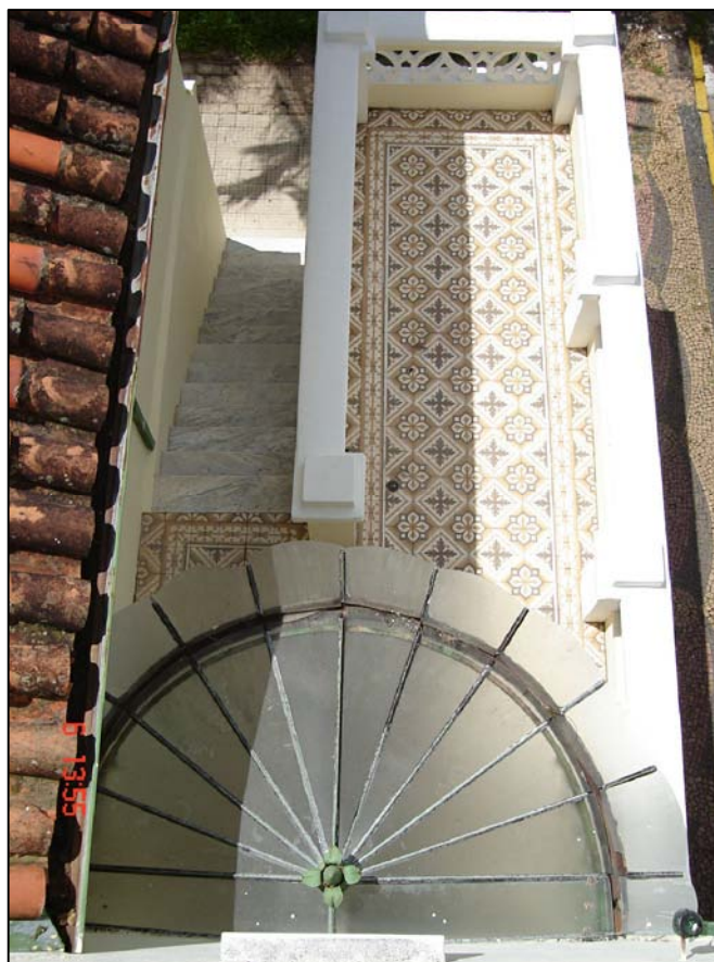
O terraço da entrada, vendo-se a cobertura em forma de concha.
