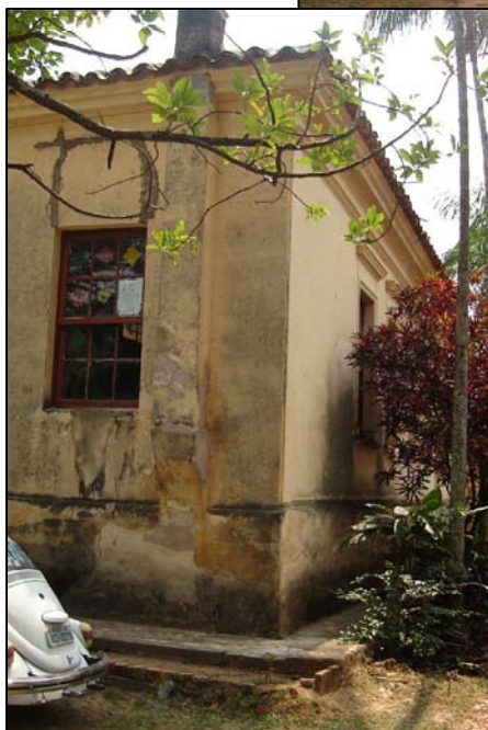
Paredes externas, com rachaduras e umidade.
