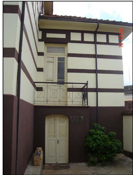
Porta de acesso ao porão, e acima sacada de dormitório do pavimento térreo.
