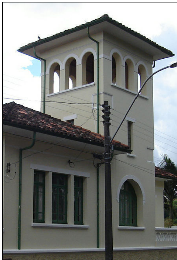
O mirante e as janelas da sala de estar, à esquerda.
