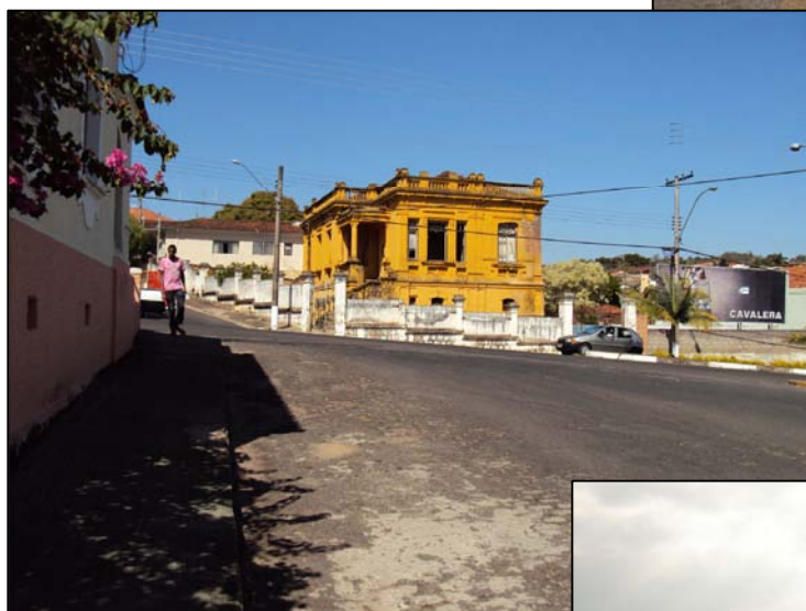
Vista do casarão a partir da Rua Vicente Gonçalves. 2010.
