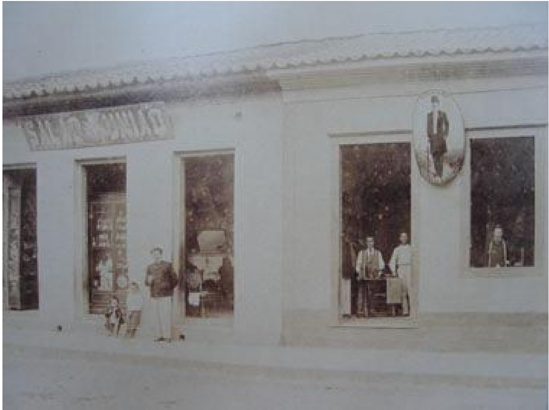
FIGURA 47. Rua José Bonifácio - Salão de Barbeiro-officina de Alfaiate.
