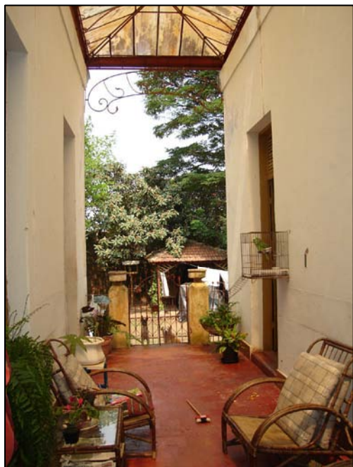
Vista do alpendre no centro da edificação, coberto com estrutura em ferro e vidro.
