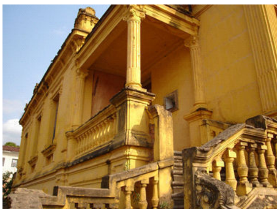
Vista do alpendre de entrada a partir da escada.
