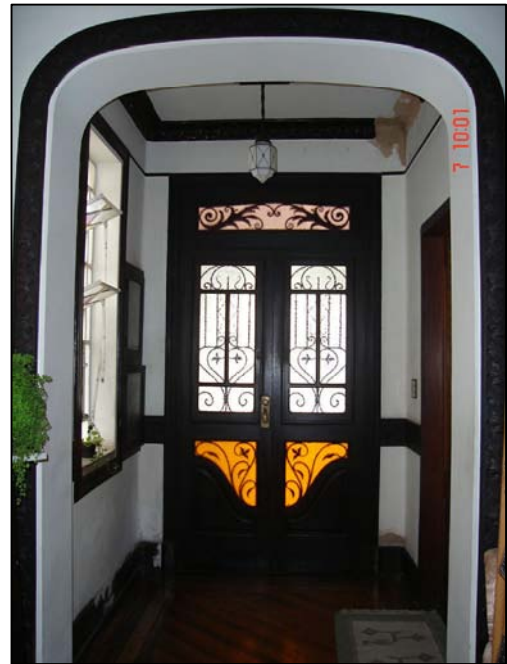
Vista interna da porta de entrada principal.
