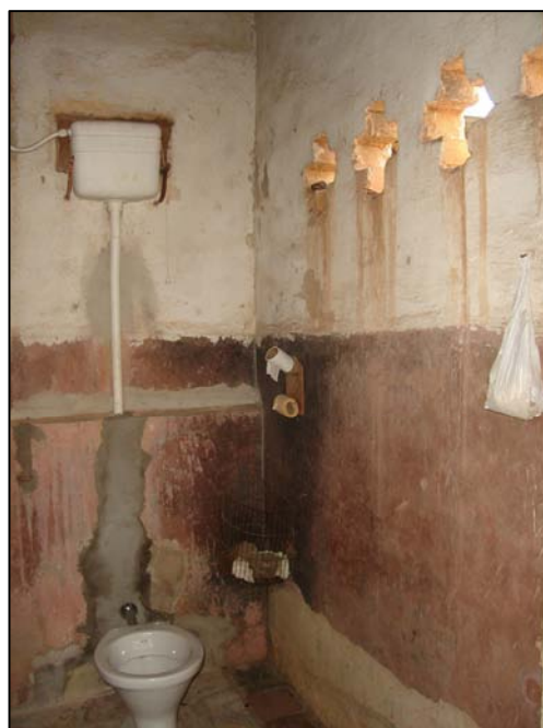
Banheiro localizado no quintal.
