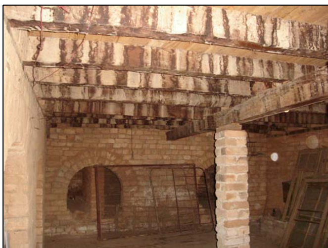
Porão, vendo-se a estrutura do piso de assoalho.
