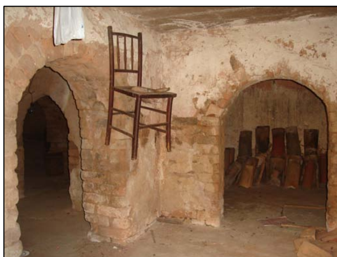
Porão, com passagens em arco.
