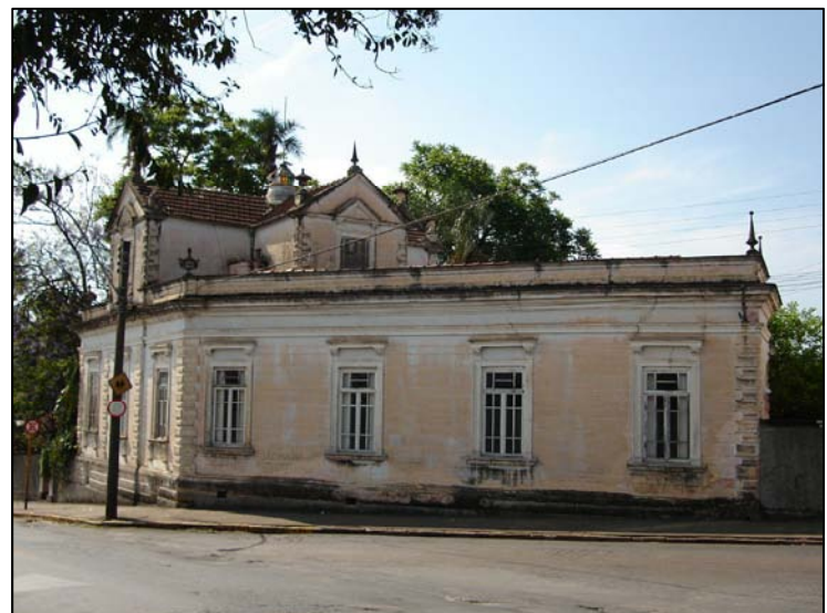
Fachada lateral do casarão, no alinhamento do lote. 2008.
