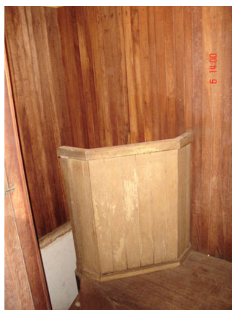
Escada, no piso intermediário, dentro do telhado.
