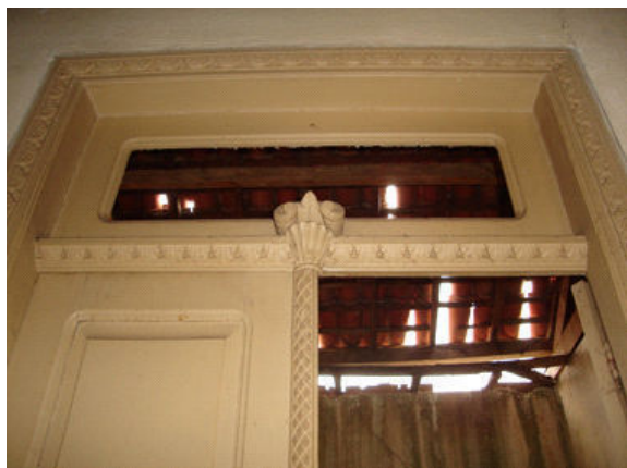
Detalhe de porta interna.
