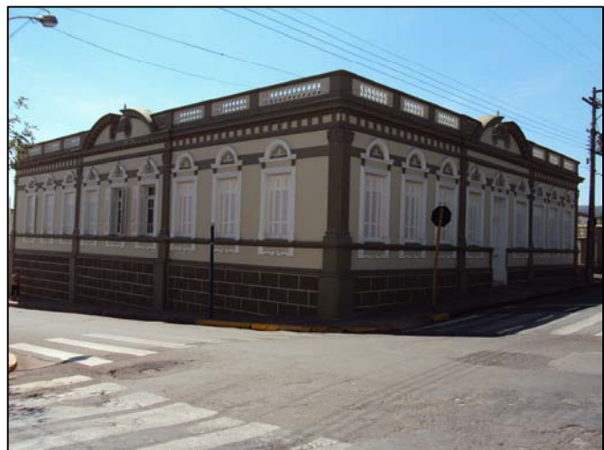
Fachadas principal e lateral. 2010.
