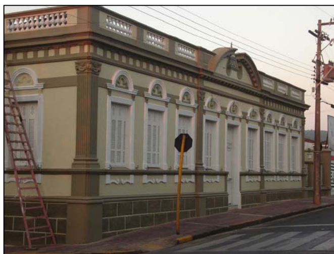
Vista da fachada principal.
