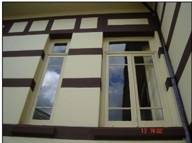
Janelas da copa e da cozinha.
