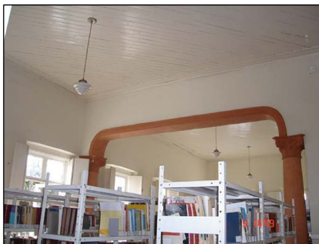
Vista de sala do térreo.
