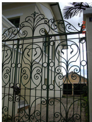
Gradil de ferro, na fachada frontal.
