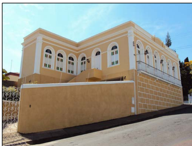
Vista da fachada dos fundos e do portão da entrada de serviços e automóveis à esquerda, em ferro trabalhado.
