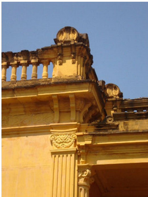
Detalhe da pilastra e da platibanda.
