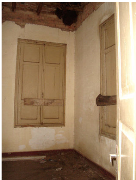
Vista de provável dormitório.
