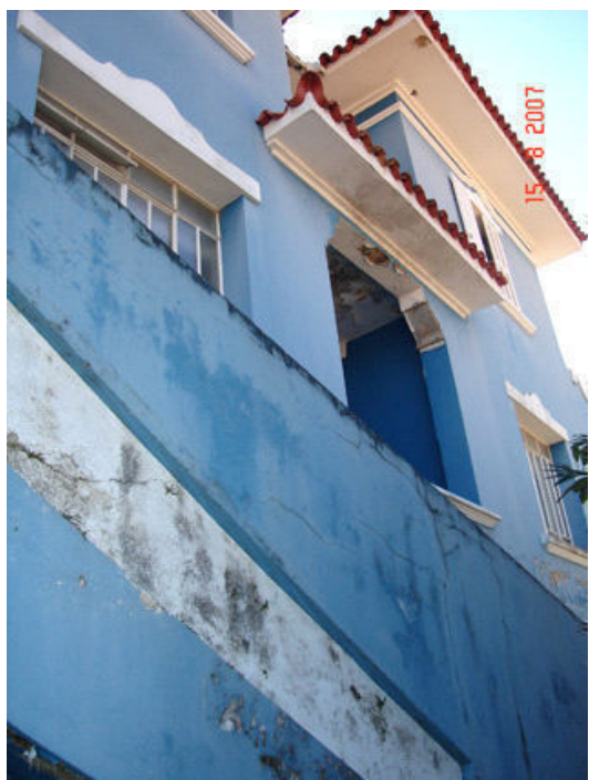
Fachada lateral, voltada para o terreno.
