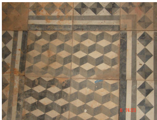
Piso do porão.
