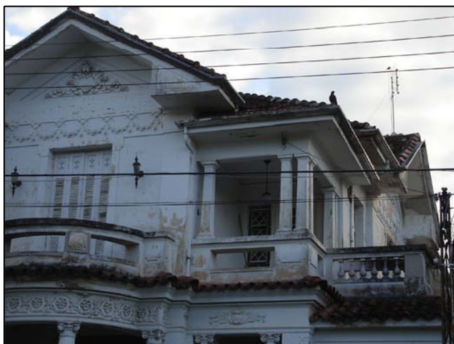
Sacada e detalhe dos telhados.
