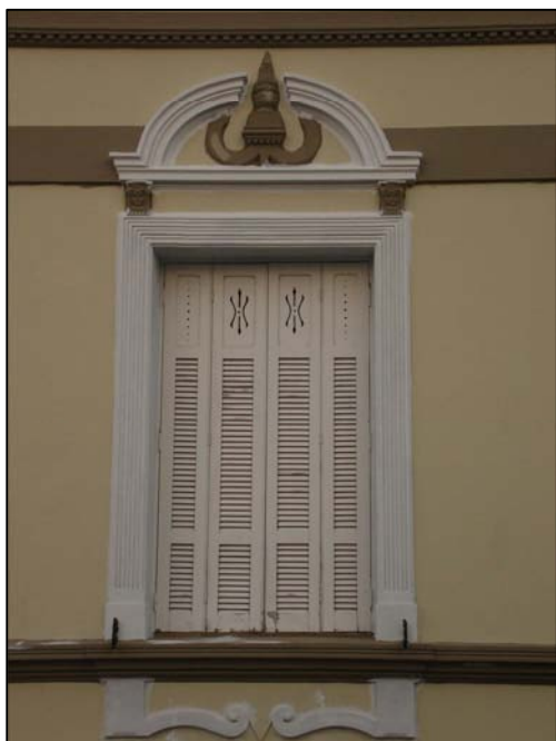
Detalhe de janela.
