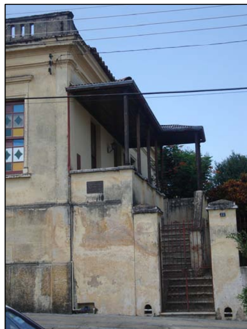
Entrada lateral e alpendre de acesso principal.
