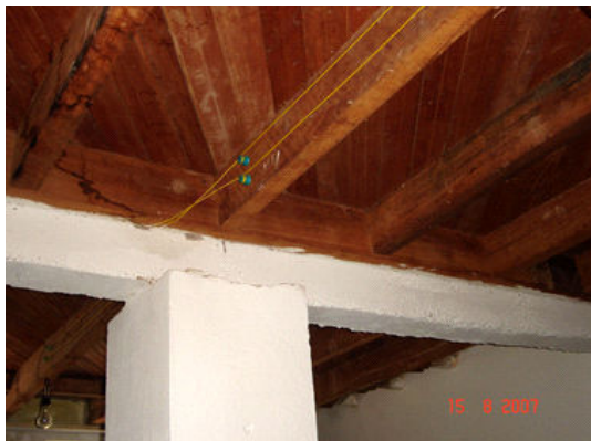
Detalhes da sustentação do piso.
