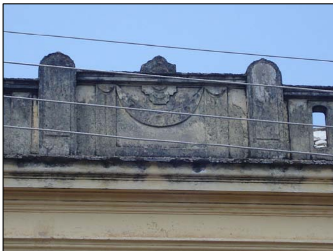
Detalhe da platibanda.
