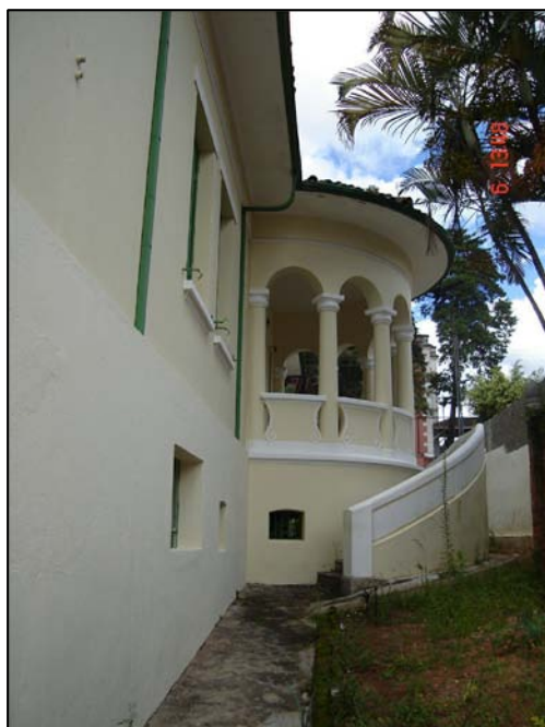
Vista da varanda da sala de jantar, voltada para jardim lateral, no recuo sem acesso à rua.
