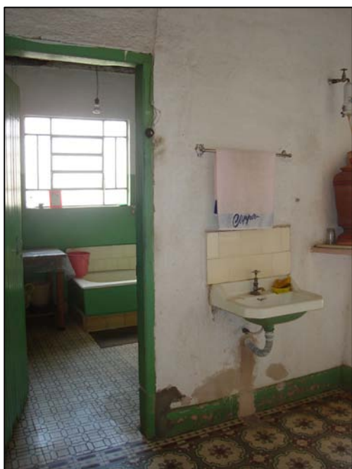
Banheiro localizado ao lado da cozinha, acessado pelo alpendre.
