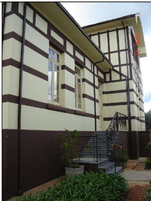
Escada de acesso ao casarão.
