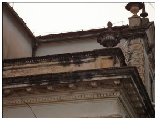
Detalhe da platibanda.
