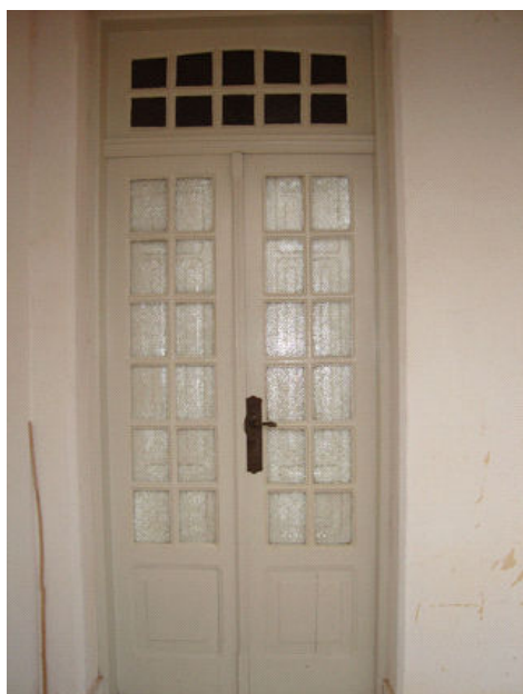
Porta do escritório do pavimento superior, para a sacada.
