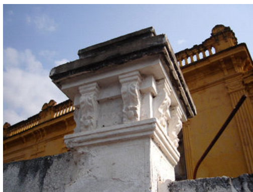
Detalhe do muro de fechamento.
