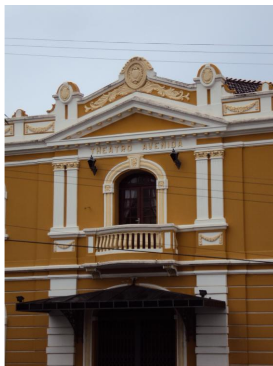
Figura 63. Detalhe do frontão do Theatro Avenida, 2010.
