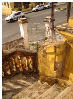
Vista do portão de acesso a partir do alpendre.
