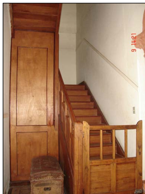
Escada de acesso ao pavimento superior.
