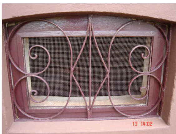
Óculo de ventilação do porão.
