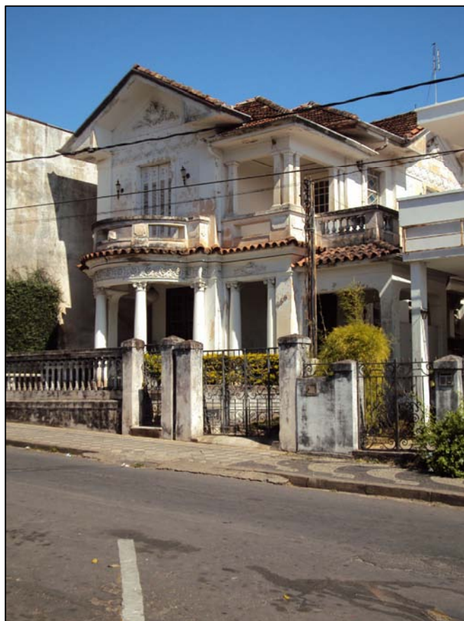
Fachadas principal e lateral. 2010.
