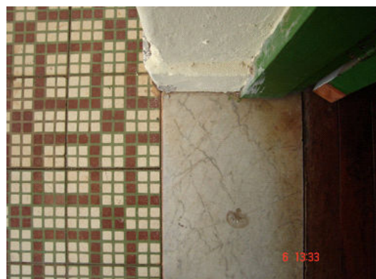
Piso da varanda da sala de jantar.
