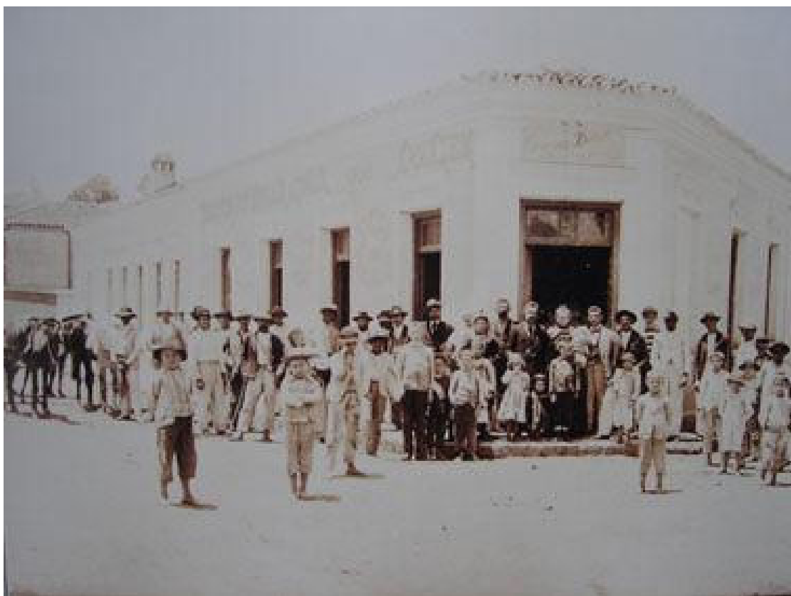
FIGURA 58. Rua 16 de Abril (em Villa Monte Negro) - Loja de barbeiro de Bonafé Casa de armazen e restaurant.
