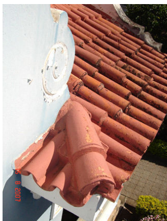
Detalhe das telhas e da voluta no acabamento do telhado.
