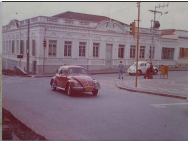
O casarão na década de 1970, com a entrada lateral fechada e as janelas com os vidros para fora. Fonte: Arquivo Melão Martini.
