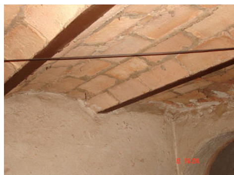
Detalhe da abobada que sustenta o piso.
