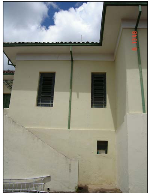
Fachada dos fundos, vendo-se as janelas da cozinha, à esquerda, e do banheiro.
