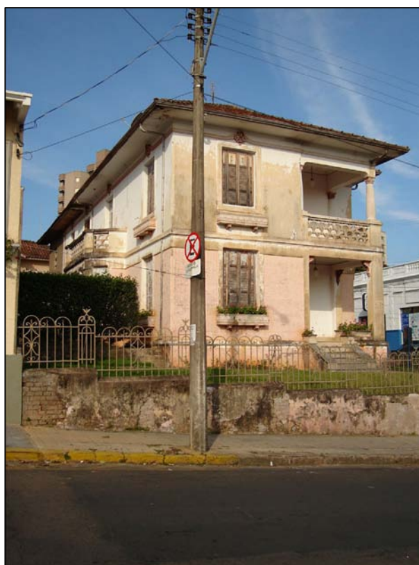
Fachada da Rua Xavier Ribeiro.
