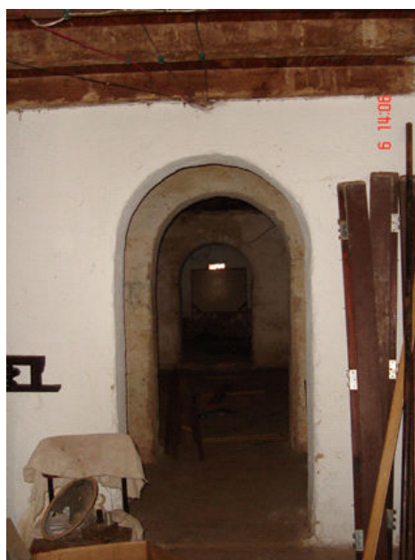
Vistas do porão, com as vigotas em madeira aparecendo.
