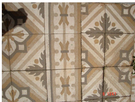
Piso do terraço da cozinha.
