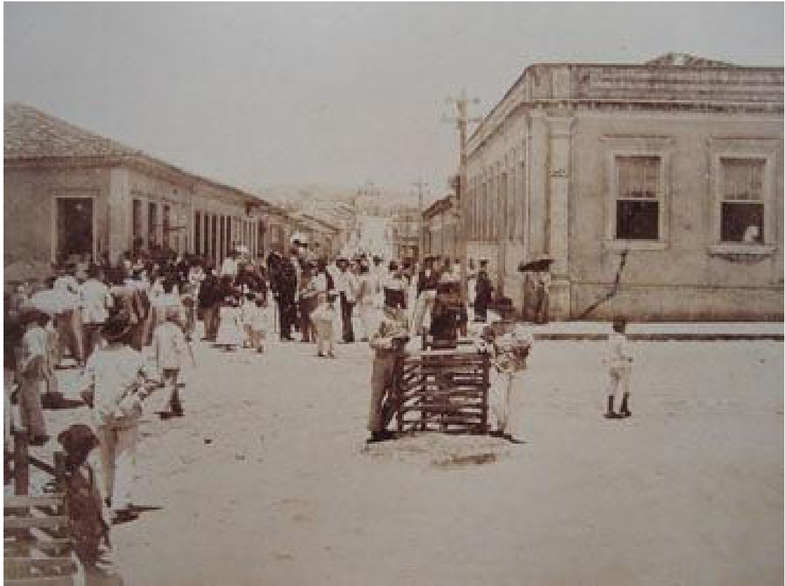
FIGURA 45. Vista da Rua José Bonifácio.
