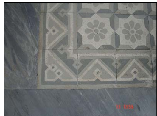
Piso em mármore e ladrilho hidráulico, do patamar da escada da entrada principal.
