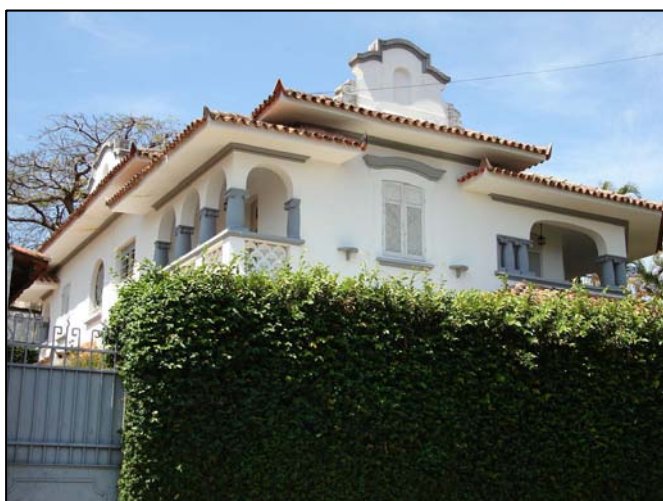
Detalhe da fachada da Rua Vicente Gonçalves.
