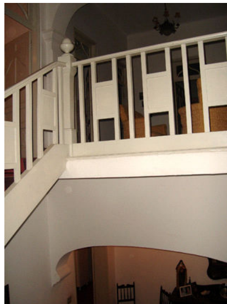
Vistas da escada e do guarda corpo.
