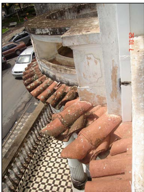
Detalhe do beiral que contorna a edificação na altura da laje do segundo pavimento.
