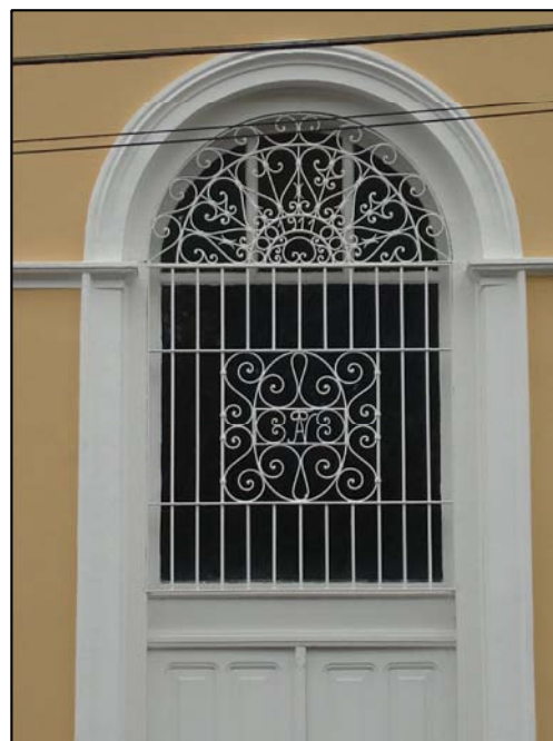
Detalhe do gradil da porta de entrada, com as iniciais AV, provavelmente inseridas em 1911, ano de uma das reformas, e pertencente ao então proprietário Almeida Vergueiro.
