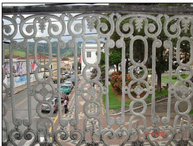
Detalhe do gradil do balcão do pavimento superior.
