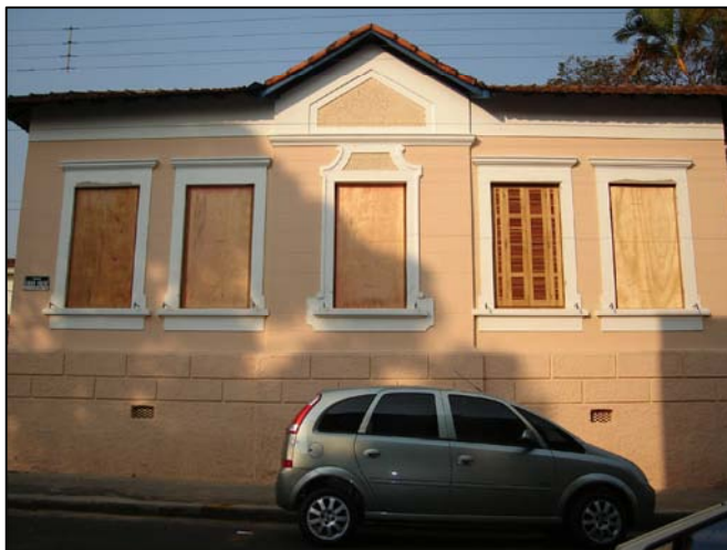
Vista da fachada principal, durante a reforma de 2007.
