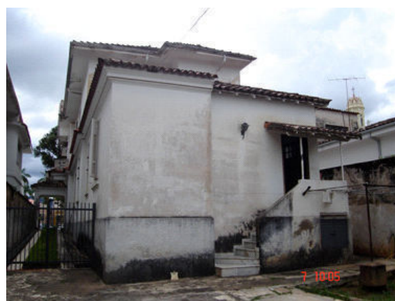
Fachada do fundo.
