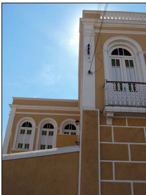
Detalhe da volumetria nos fundos.
