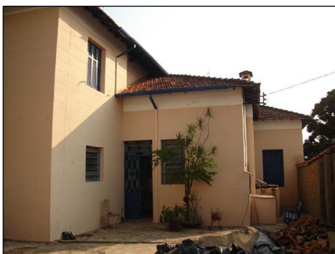
Fachada dos fundos, vendo-se o segundo pavimento.
