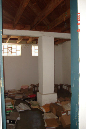
Pilar, vigotas de sustentação do piso assoalho, e janelas, no porão.
