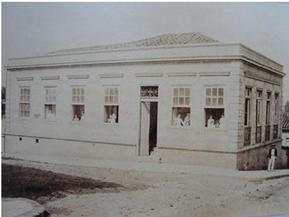
FIGURA 33. Rua 16 de Abril - Casa e res. do Cap. Americo de Almeida Vergueiro.
