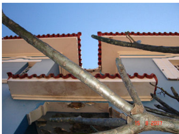
Detalhe dos telhados.
