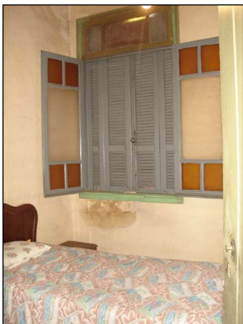
Manchas de umidade nas paredes.
