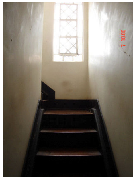
Escada de acesso ao andar superior a partir da zona de serviços.
