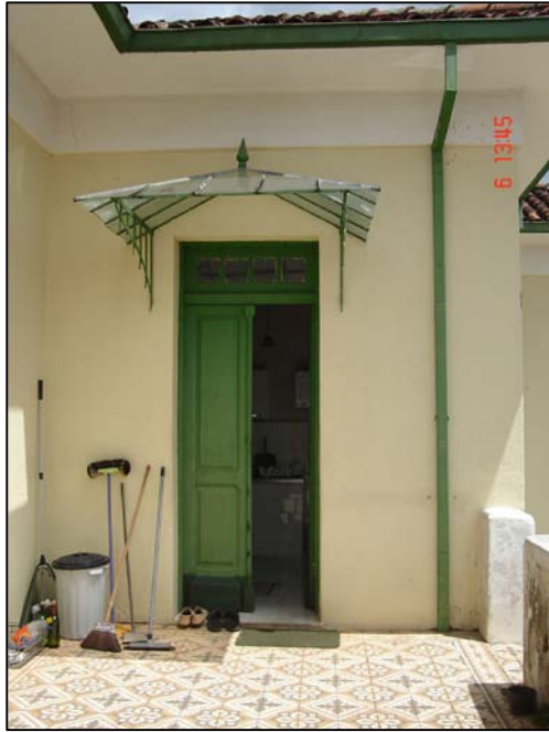
Porta da cozinha, com cobertura em ferro e vidro.
