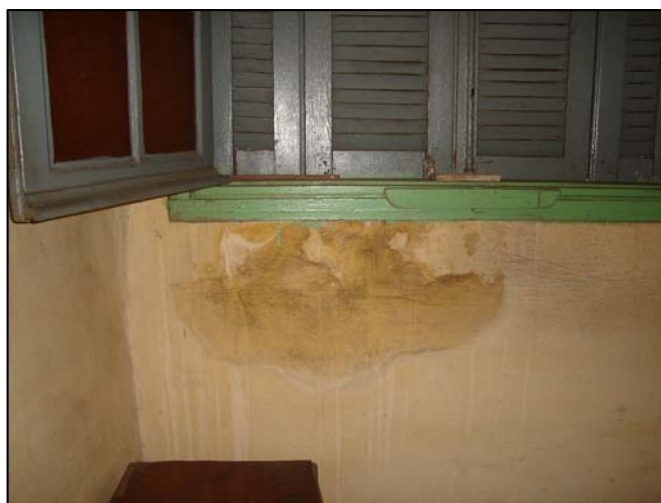
Manchas de umidade nas paredes.
