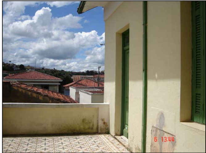
Terraço da cozinha, vendo-se ao fundo a porta de um dos dormitórios.
