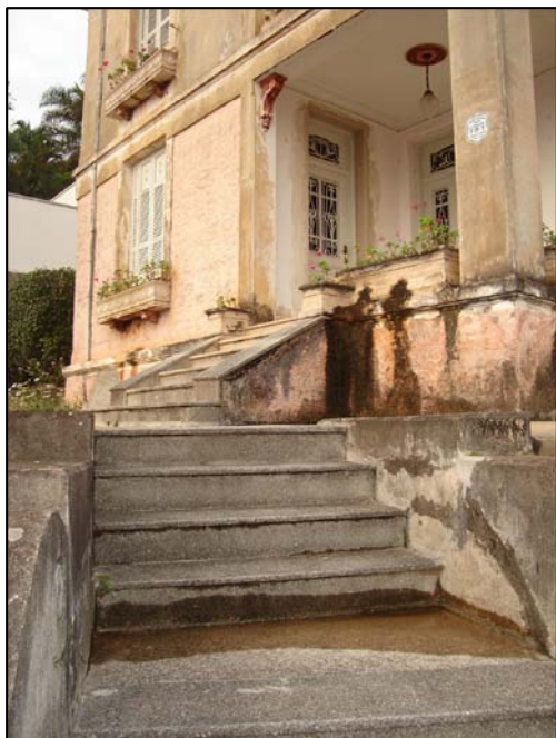
Escada do acesso principal.
