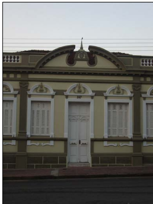
Conjunto da entrada principal, encimado por frontão cimbrado interrompido.
