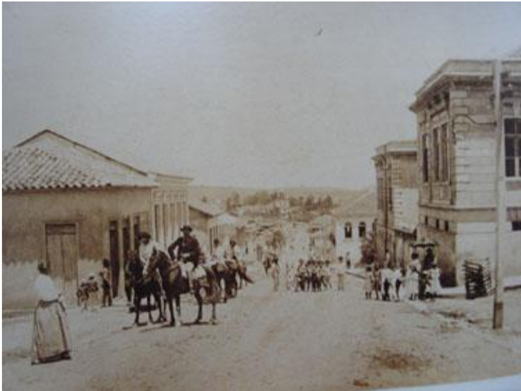
Figura 68. Vista de um trecho da Rua 16 de Abril, que liga a Praça da Matriz à Estação Ferroviária. Fonte: 'Álbum do Pinhal', 1903.
