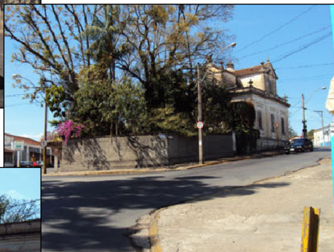
Vista do casarão e do lote a partir da principal rodovia de entrada da cidade. 2010.
