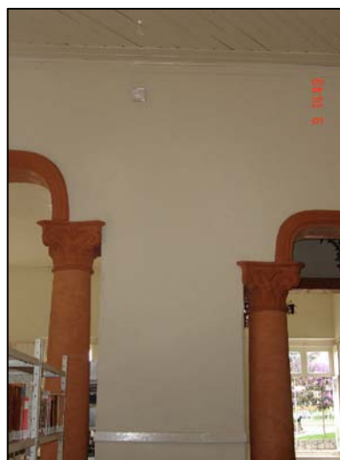
Colunas dos pórticos no térreo.
