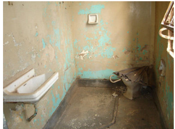
Vistas do banheiro.
