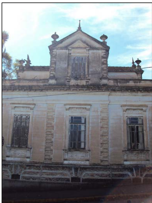
Detalhe da fachada construída no alinhamento.
