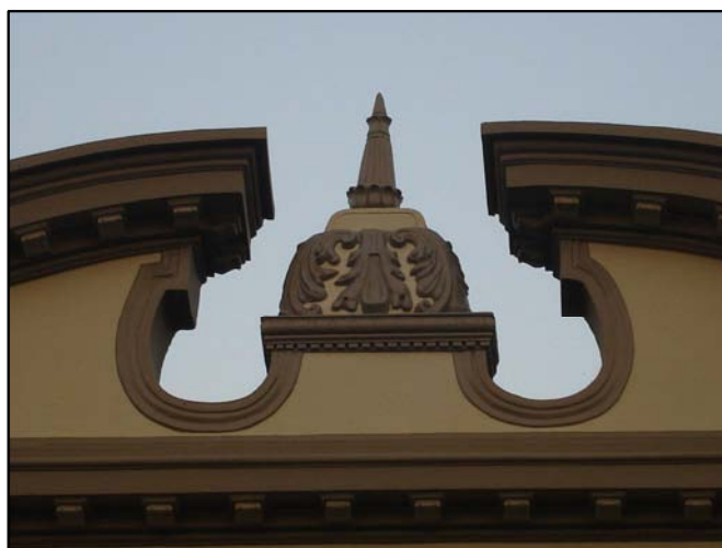
Frontão cimbrado restaurado. 2008.
