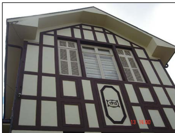
Janelas do sótão, no pavimento superior.
