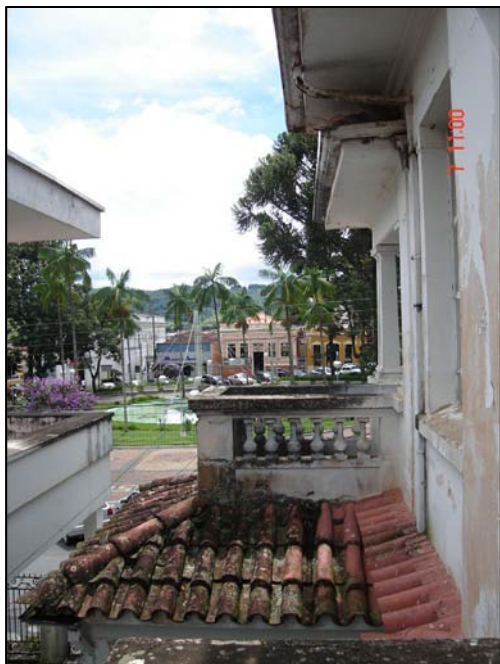
Sacada do banheiro, no segundo pavimento.
