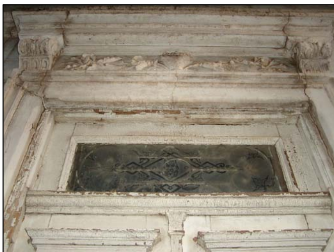
Detalhe de bandeira de vidro da porta principal.
