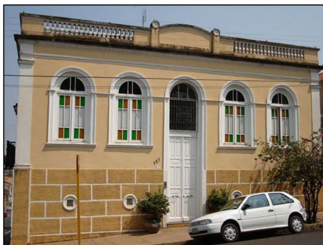
Fachada principal, antes da nova pintura. 2005.
