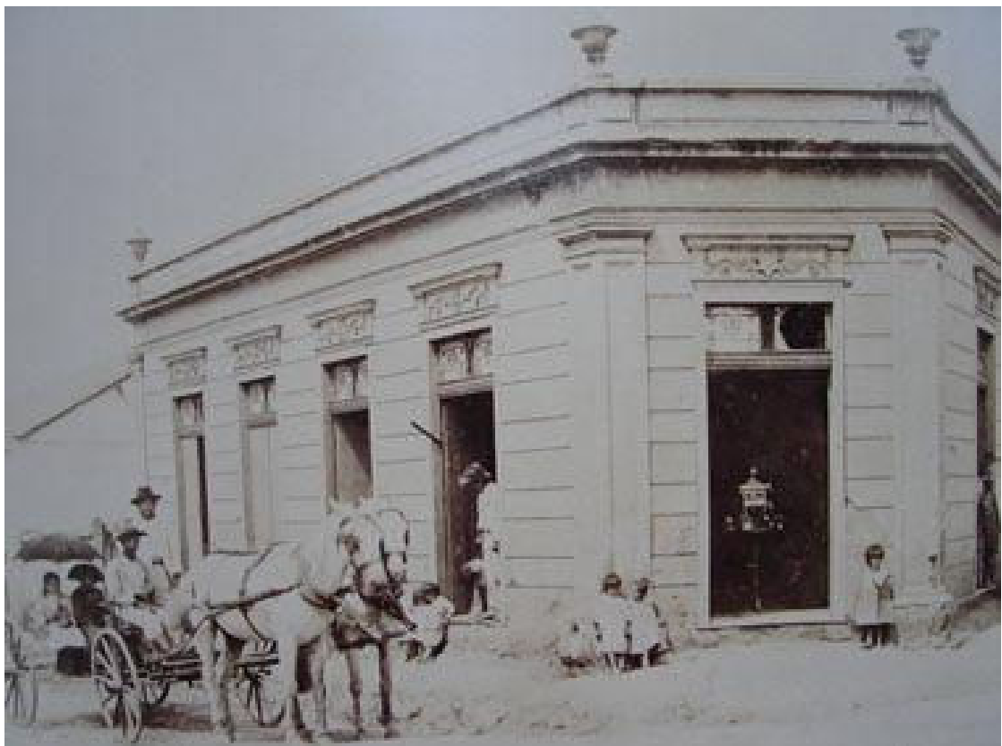
FIGURA 70. Villa Monte Negro - Rua General Carneiro - Casa e res. de José Luiz da Costa.
