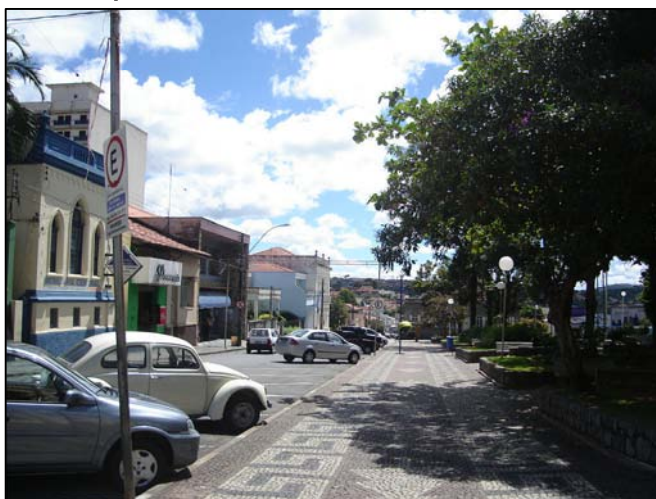
Vista do casarão no fundo, descendo-se a partir da Igreja. 2008.
