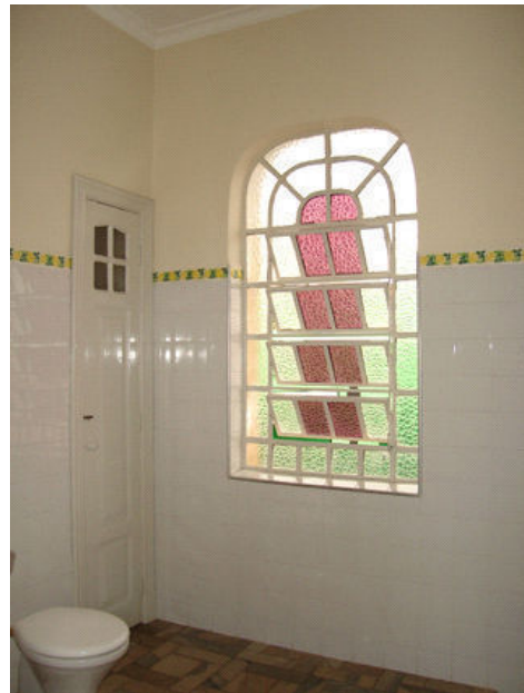
Banheiro do andar superior.
