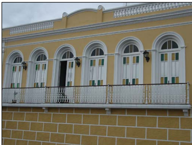
Portas e balcão de ferro batido, andar superior, fachada lateral.
