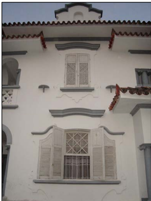
Detalhe da fachada da Rua Vicente Gonçalves.
