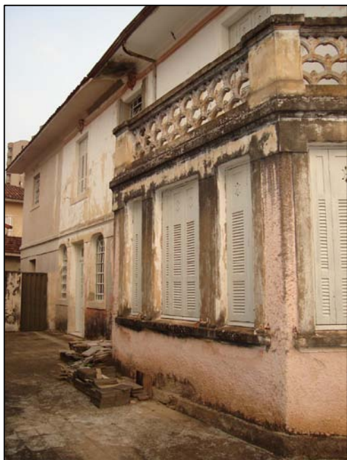
Fachada lateral interna.
