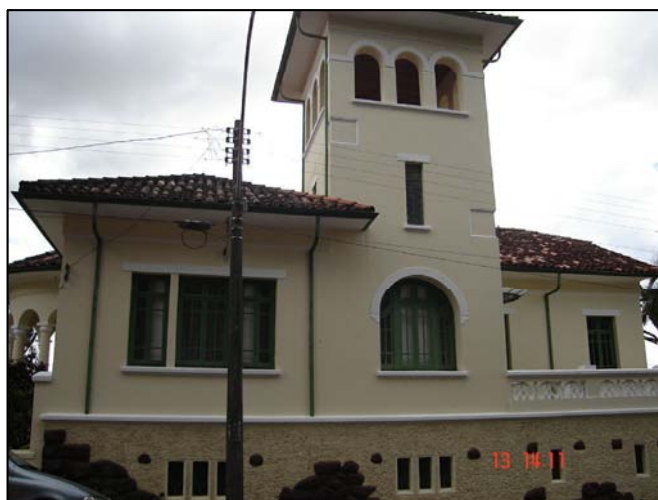
Fachada principal, no alinhamento.
