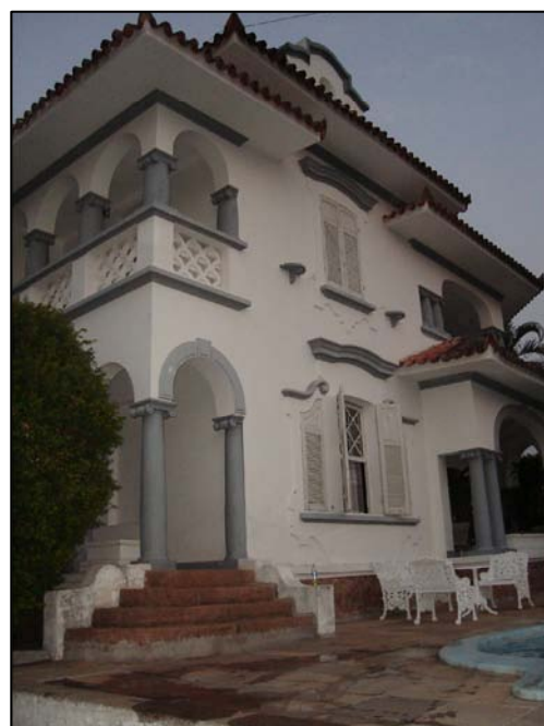
Fachada voltada para a Rua Vicente Gonçalves.
