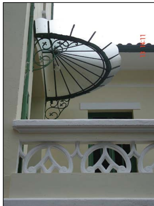
Cobertura de ferro e vidro da porta de entrada, com gradil trabalhado em art nouveau.
