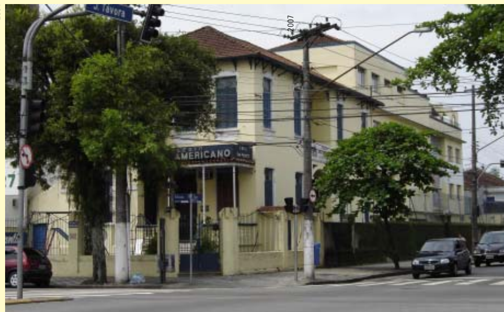
Vista que mostra a reentrância onde se localiza a entrada lateral
