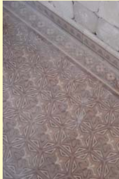
Pisos em ladrilho hidráulico - alpendre e terraço
