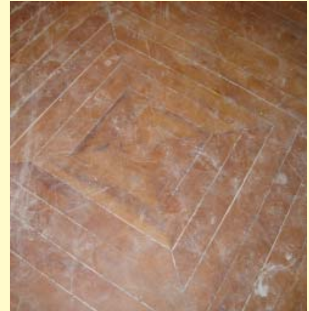
Piso em madeira com tabeira e régua dispostas à 45° - pavimento superior
