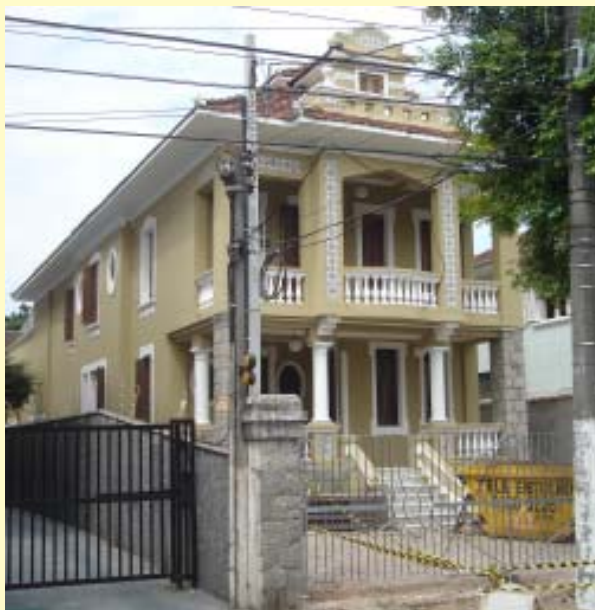
Vista da fachada principal ...
