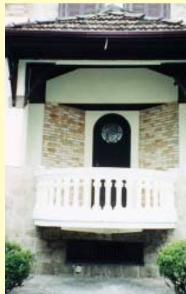
Alpendre frontal - balastrada, porta em arco pleno e diferentes faixas de revestimento
