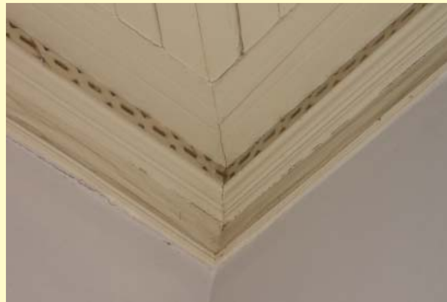
Forro em madeira, tipo paulistinha com tabela, aba e régua dispostas à 45°. Detalhe dos aeríferos para ventilação
