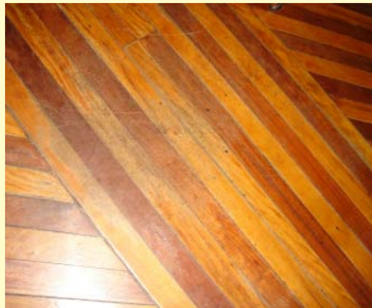
Piso em madeira com tabeira e régua dispostas à 45° - sala de piano
