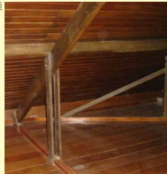
Detalhe da estrutura de sustentação da cobertura
