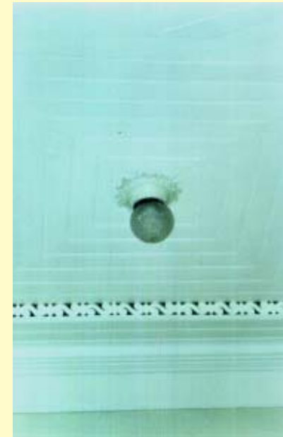
Sala de jantar - forro em madeira , tipo paulistinha com tabeira, aba , cordão e régua dispostas em vários sentidos formando desenhos. Detalhe dos aeríferos para ventilação e da iluminação embutida
