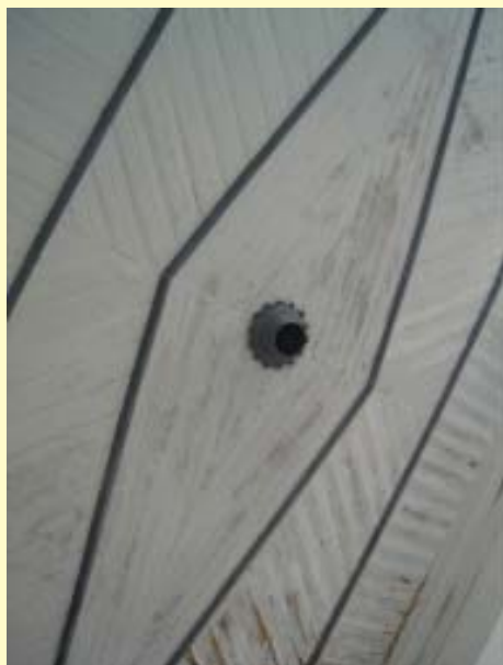
Alpendre - forro em madeira, tipo paulistinha com tabeira, aba e régua dispostas em várias direções formando desenho de losango
