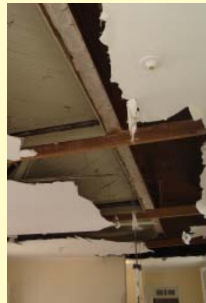
Forro original em madeira com tabeira, aba e régua dispostas à 45° revelado com a retirada do forro de gesso - pavimento superior
