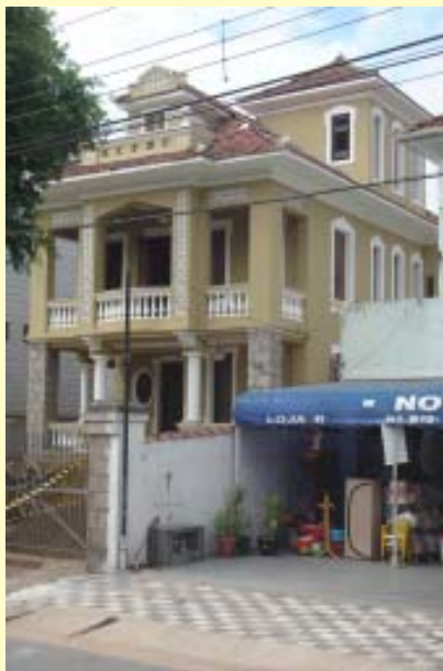
... com destaque da caixa de circulação ressaltada volumetricamente
