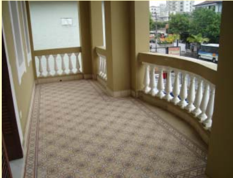
Alpendre frontal do pavimento térreo com piso em ladrilho hidráulico decorado - entrada principal
