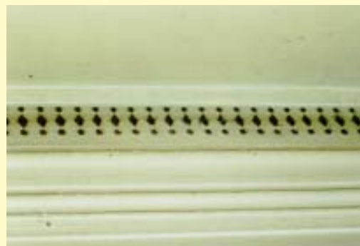
Detalhe dos aeríferos do forro para ventilação
