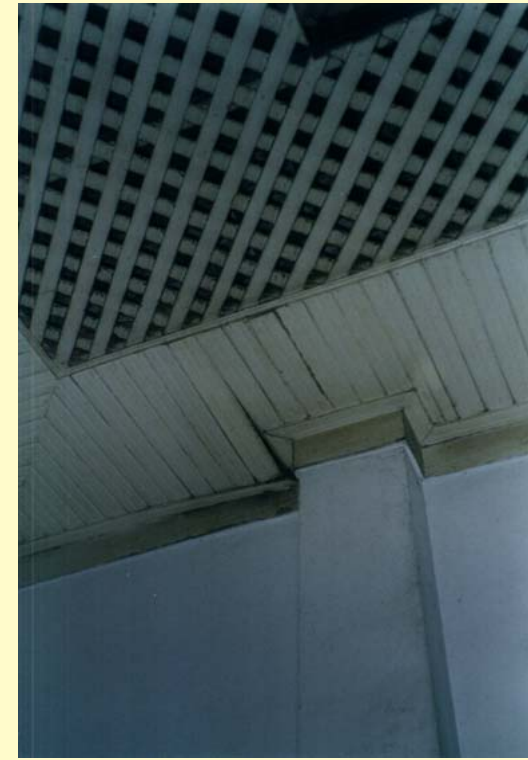
Cozinha - "Ripamento em xadrez" do forro: ventilação e chaminé para aspiração de odores e gases
