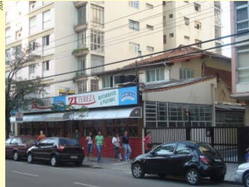
Fachada lateral esquerda. Notar a presença de elementos originais tais como o volume do telhado e o arco que marca o acesso principal
