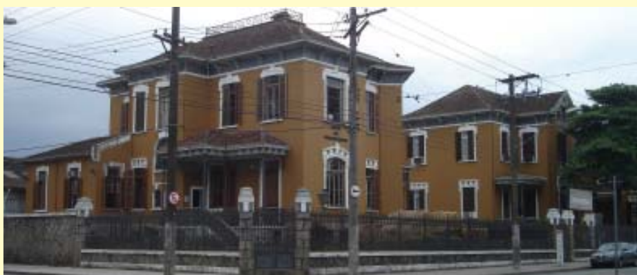
Casas I e II - Avenida Rodrigues Alves esquina com rua Conselheiro João Alfredo
