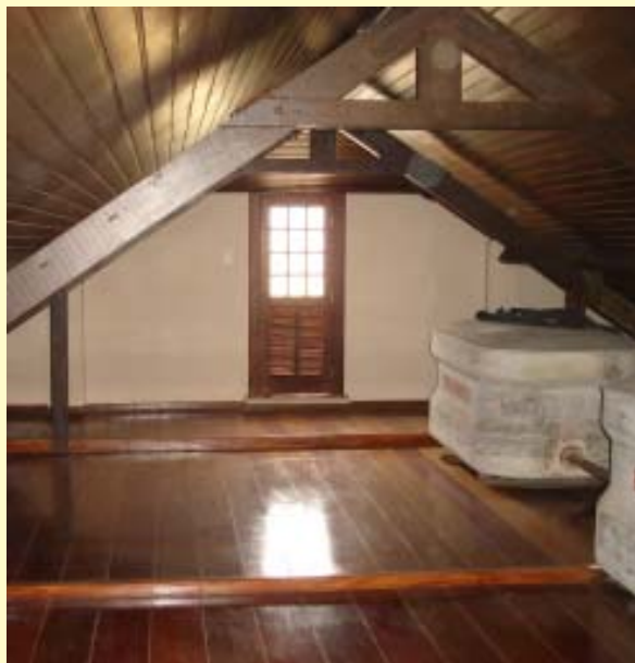
Sótão com vista das caixas d'água e da porta de acesso ao terraço
