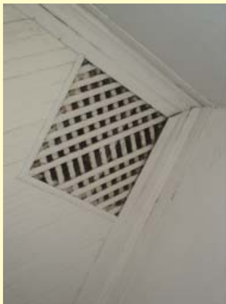
Cozinha - forro em madeira, tipo paulistinha com tabeira, aba e régua dispostas á 45°. Detalhe do "ripamento em xadrez" para ventilação
