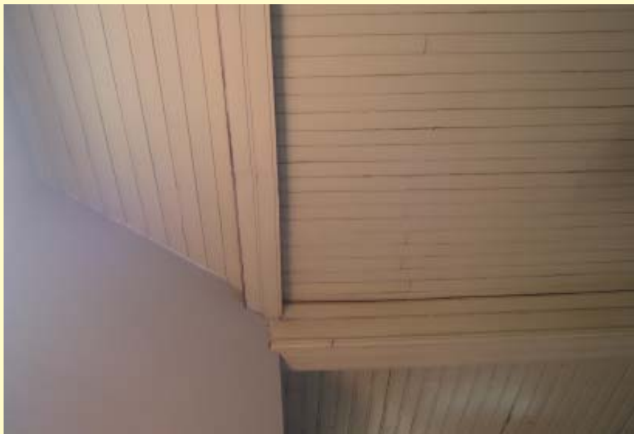
Forro em madeira, tipo paulistinha com tabela e régua dispostas no sentido transversal em primeiro plano e longitudinal ao fundo, evidenciando que anteriormente se tratavam de dois ambientes distintos
