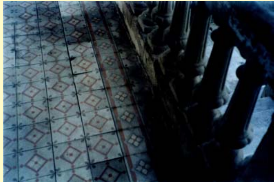
Piso em ladrilho hidráulico e balaustrada originais do alpendre
