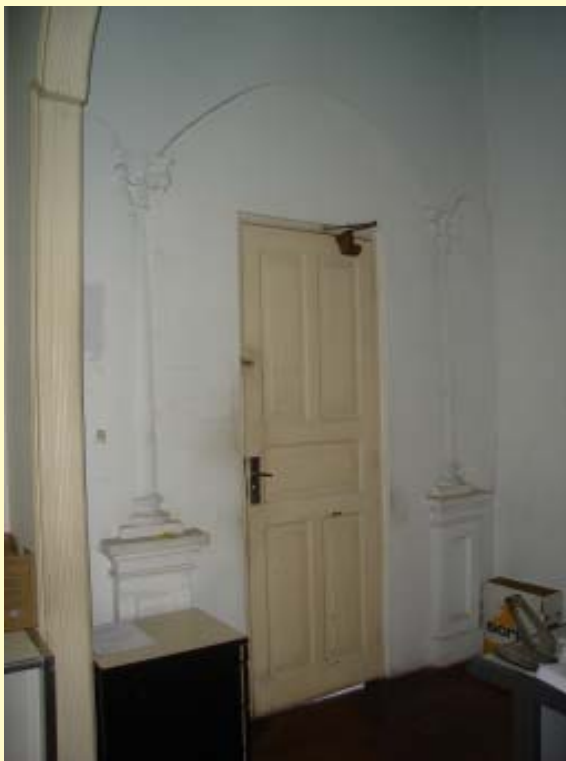
Emparedamento dos arcos que separavam os dois ambientes de estar localizados na parte frontal da construção
