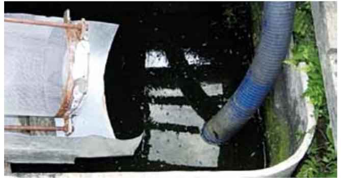
**Figura 16.** Bombeamento da caixa de decantação para reúso.
