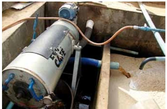
**Figura 18.** Filtro de resíduos sólidos com tanque de decantação.
