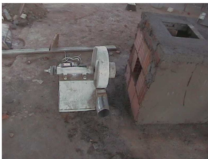
Figura 3.5: Acoplamento do ventilador ao misturador.
