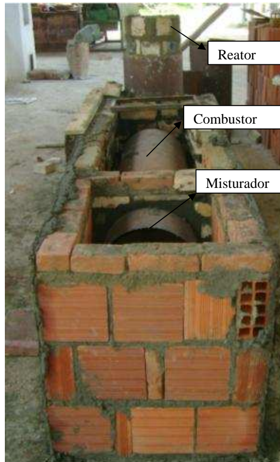
Figura 3.3: Gaseificador em construção.
