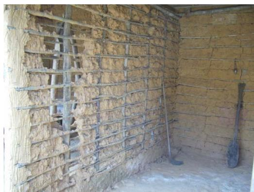
**Figura 40:** Estrutura de parede de pau a pique
